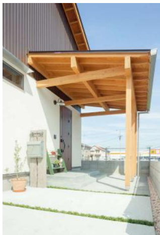
◆駐輪スペースも兼ねた、大きく伸びた立派な玄関庇
