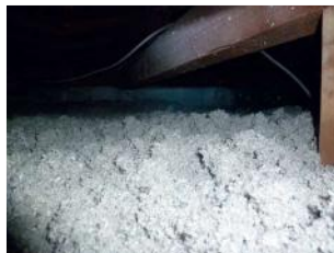
天井・断熱(セルロースファイバー)
