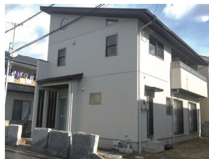
▲外壁塗装のリフォームを施しました
